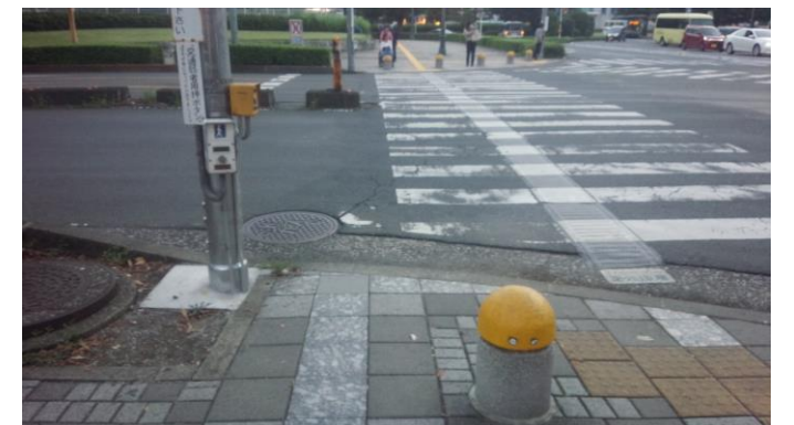
航空公園駅前 点字ブロックから離れた押しボタン
